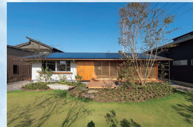
設計:Mアトリエ 施工:橋本工務店
