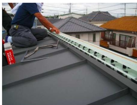
③換気棟カバーを取付けます。
