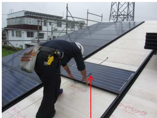
モジュール裏面のモジュールケーブルを上下に取り出し、水下の方へ後退しながらモジュールをスライドさせます。左右のバランスが大事です。
