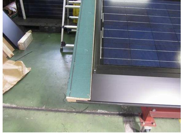
③ケラバ包みを被せて、軒先に鏡板を取付けて納めます。
