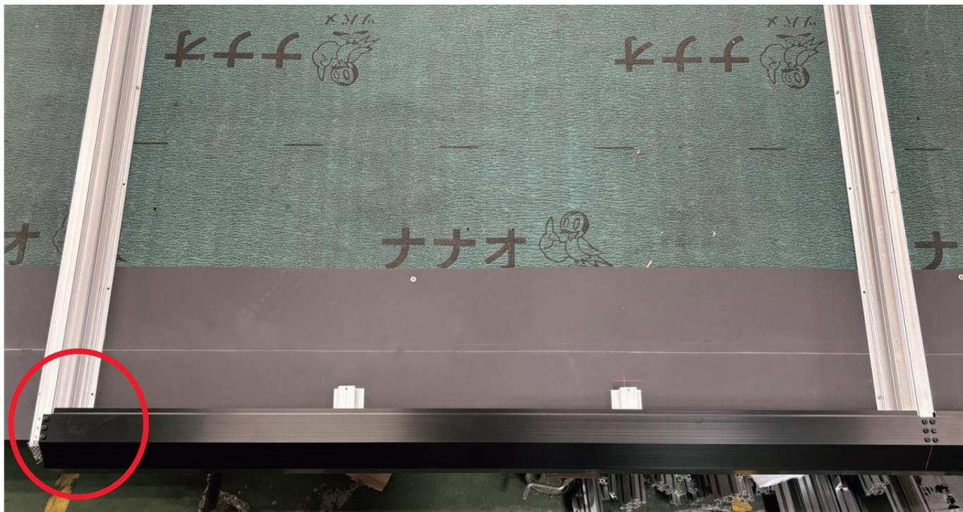
軒先部品は、なべドリルビス (M4×10) で留めます。その際ビスが破損しないように**クラッチ付き電動ドライバー**または**手締め**で行います。
