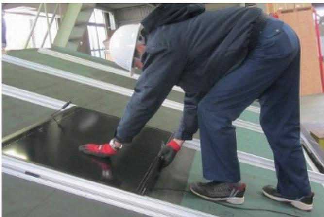
④モジュールと引込ケーブルのコネクタをカッチと音がするようにつなぎます。
