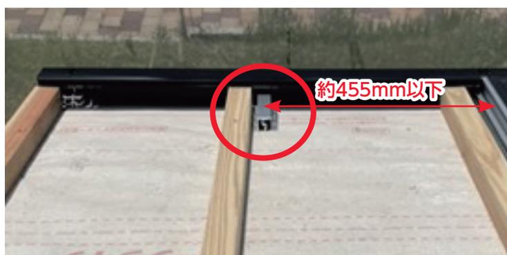
アルミ棧とアルミ棧 (ケラバ軒先用) の距離が455mm以上になる場合は、必ず軒先部品受け金具を中間に設置します。
