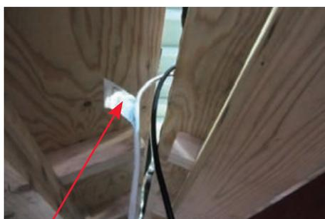
換気棟の換気口から取込例
