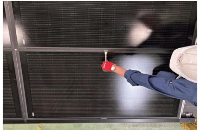
1枚目のモジュールのケーブルプラスと補助ケーブルのマイナスを結線して始まります。
