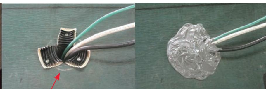
野地板にPF管の上部をカットして納める場合は、ケーブルを通した後、穴全体をコーキングしてください。
