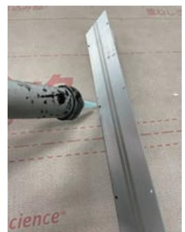
①軒先用のアルミ棧は先端に6個の穴が開いています。
