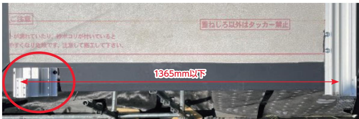
ケラバ部分の納めにアルミ棧 (ケラバ軒先用) を1365mm以下で取付ける。
